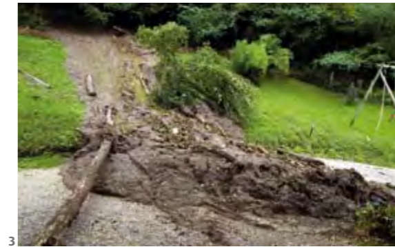
1- Effondrement d'une route suite à un mouvement de terrain. 2- Un glissement de terrain en montagne. 3- Une coulée de boue dans un jardin (Savoie).
