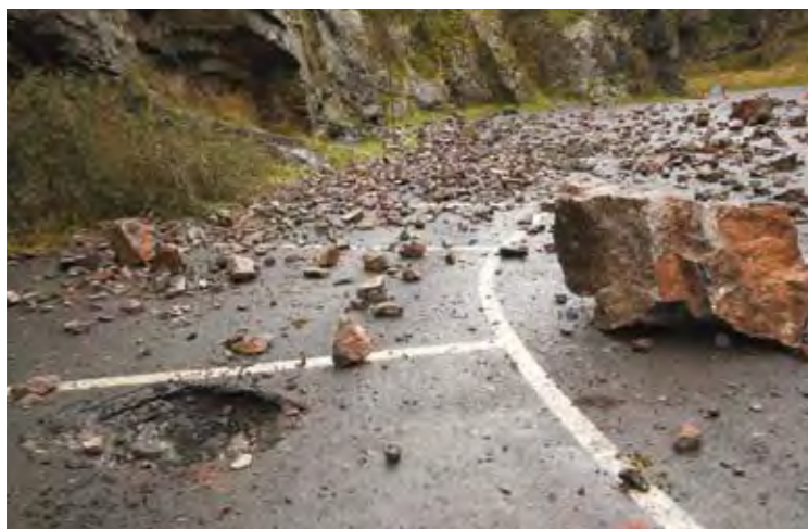
Les chutes de pierres impactent souvent les routes.
