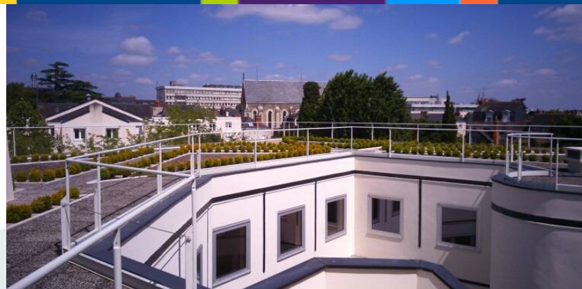
Terrasses végétalisées mises en place sur les bâtiments de la DDT
