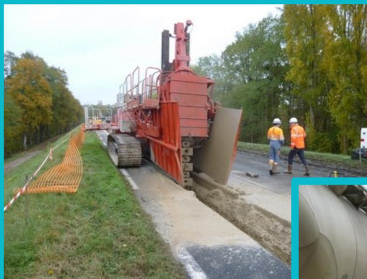
Les écrans étanches seront réalisés en utilisant la technique innovante du « mélange en place ».
