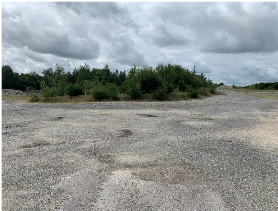
Figure 1 : Surface imperméabilisée au droit du site d'étude (TotalEnergies, juillet 2021)
