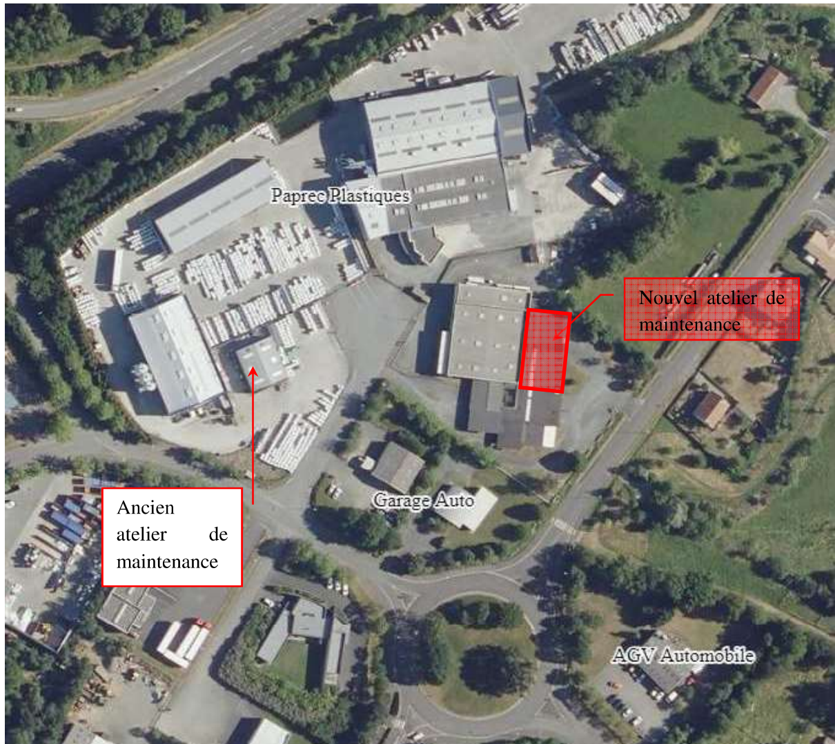
Figure 7. Emplacement du nouvel atelier de maintenance
