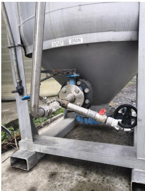
Photo 1 : Prélèvement du filtre à charbon
