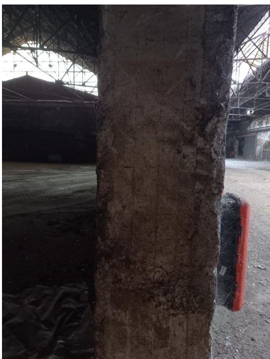
Mur de 63 cm d'épaisseur, en pierre ardoisée, participant à la limitation de la propagation du feu en limitant le rayonnement thermique vers le hall non exploité.
