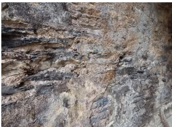
Mur de 63 cm d'épaisseur, en pierre ardoisée, participant à la limitation de la propagation du feu en limitant le rayonnement thermique vers le hall non exploité.
