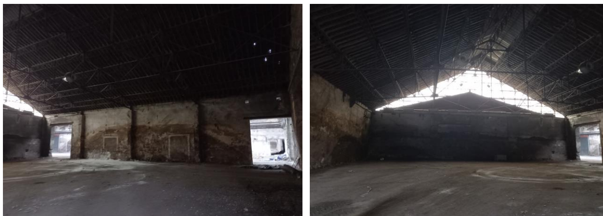
Vue dans le hall de stockage : 2 portes vers le hall non exploité – faitage en polycarbonate.
