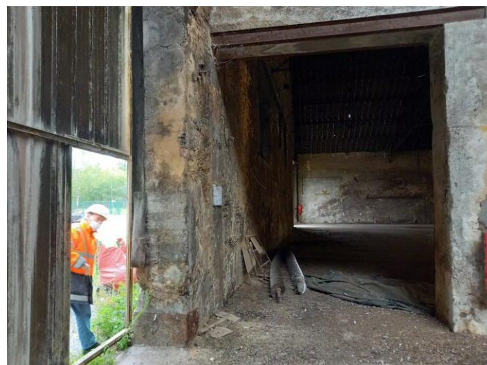
Porte piétonne pour l'évacuation, intégrée à la porte engin façade Sud.
