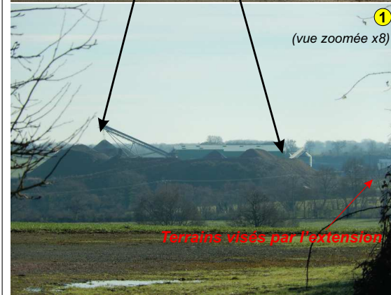
Vue sur les installations de traitement et les parcelles de l'extension (zoom x8)
