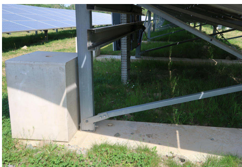
L'utilisation des longrines en béton doit être limitée
