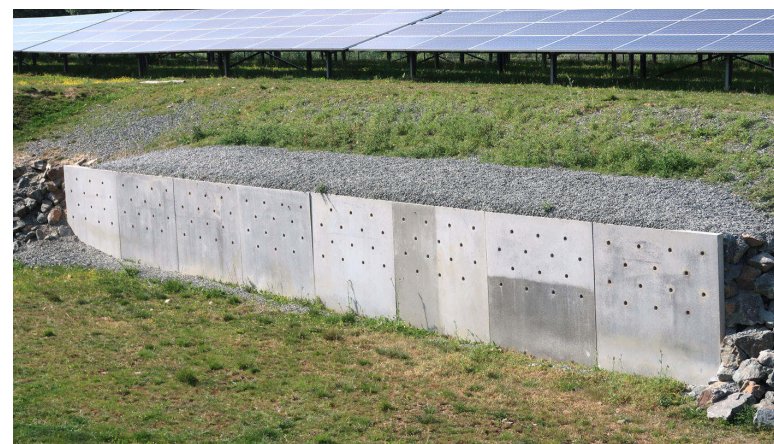
Mesure d'accompagnement pour la faune : aménagement pour la nidification des hirondelles sur la centrale photovoltaïque de la Petite-Vicomté aux Ponts-de-Cé.
