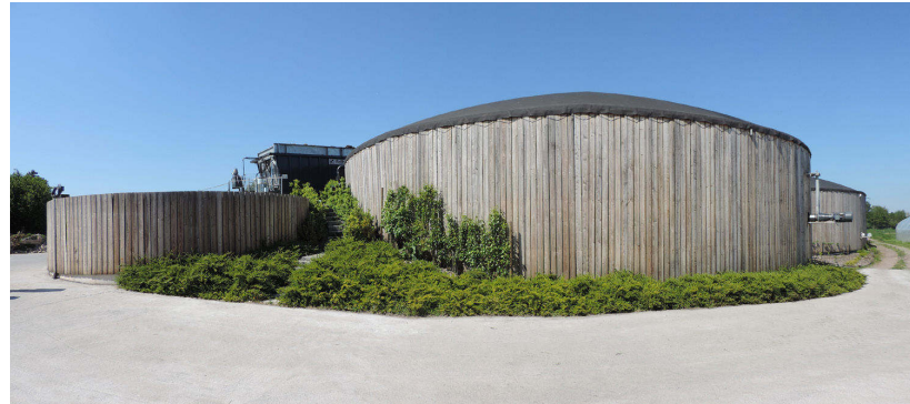
Réponse architecturale pour un bâtiment technique grâce à l'utilisation du bardage bois, des baches grises et la végétalisation en pied de digesteur.
