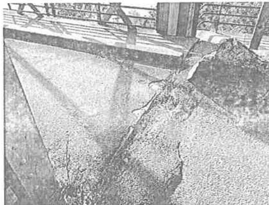
Déformation de l'enrobé aux extrémités du pont
