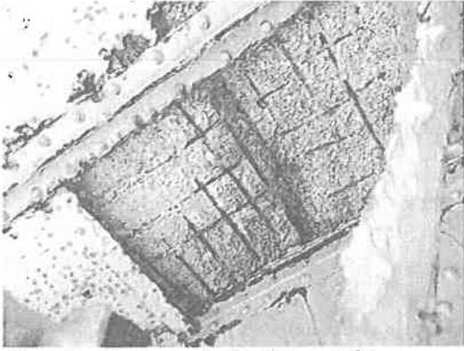
Vue du dessous du tablier après retrait d'une tôle menaçant de chuter (2013)
