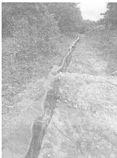
Figure 12 : bâche enterrée avec bavolet et tremplin (Source : Ecosphère)
