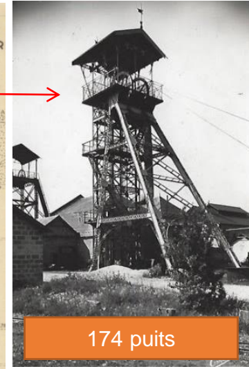
Chevalement du Puits n°8 Trélazé source : ACVFTI
