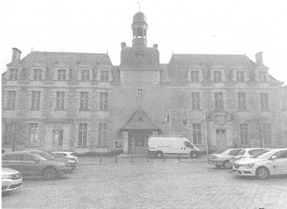
Façade nord de l'hôtel de ville
