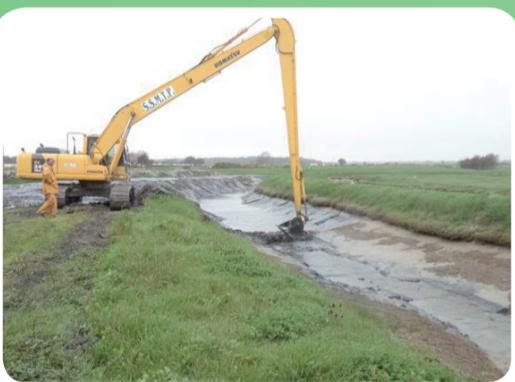
Un curage adapté permet le maintien des fonctions hydrauliques, écologiques et économiques du marais.
