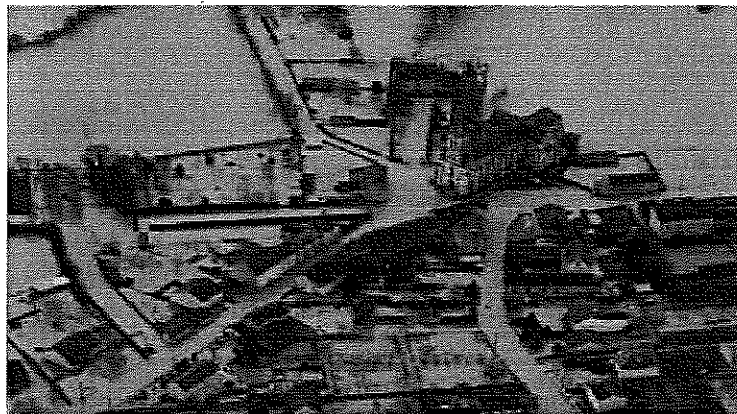
Saint-Aubin du Pavoil en 1995 (Photo Edange)
