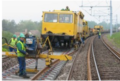
Longs Rails soudés sur traverses béton
