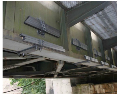
absorbeur sur platelage
