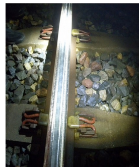
Rail après meulage
