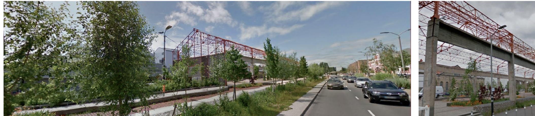
- Reconversion d'un Hangar en Square.
