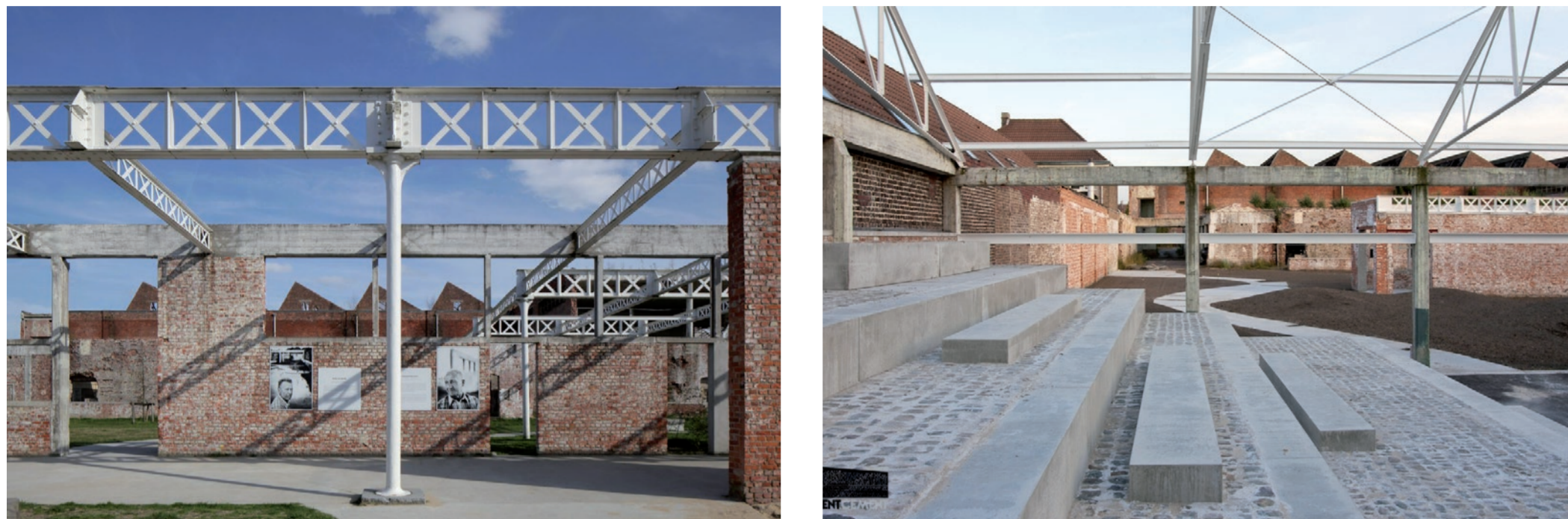
- Reconversion d'une firche industrielle en Parc
