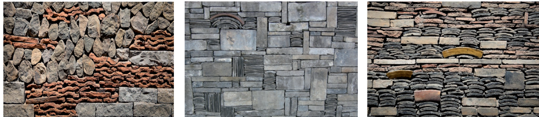
- Exemple de murs en matériaux issuent de la démolition.
