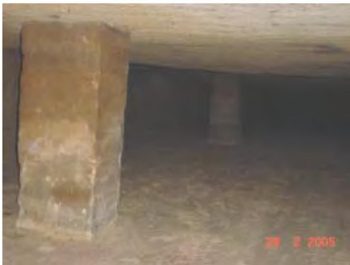
*Dans certaines zones, le recours à des piliers de confortement artificiels a donc été nécessaire.*
