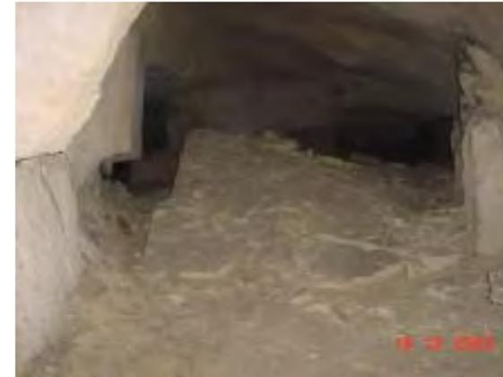
Galerie classée en aléa fort : On constate une chute de toit de plusieurs m<sup>3</sup>.
