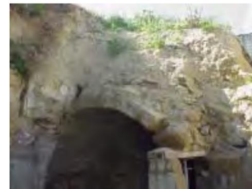
Exemple d'aléa faible : bien qu'étant d'aspect évolutif (roche plutôt friable), aucune fracture ne découpe ce pan de Coteau qui, de plus, n'excède pas 5 mètres de hauteur (Turquant).
