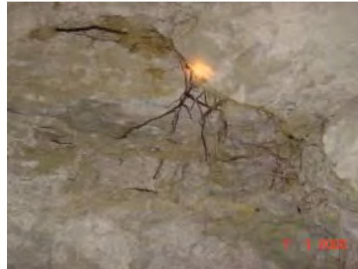
*Chute ponctuelle du toit d'une cavité sous l'action des racines*
