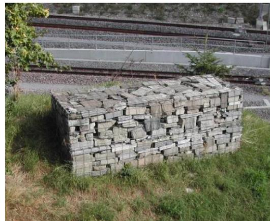
FIGURE 47 : EXEMPLE DE GABION FAVORABLE AUX REPTILES (SOURCE : CFF)
