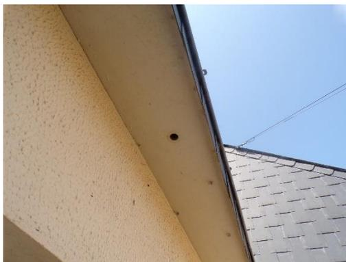
FIGURE 8 : GRILLE D'AÉRATION MANQUANTE PERMETTANT L'ACCÈS DE CAVERNICOLES À L'AVANT-TOIT
