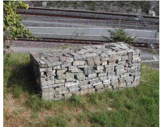
FIGURE 36 : EXEMPLE DE GABION FAVORABLE AUX REPTILES (SOURCE : CFF)
