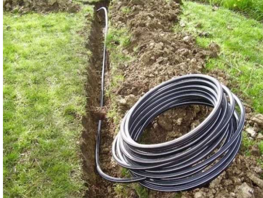
Gaine PEHD protégeant la fibre optique
