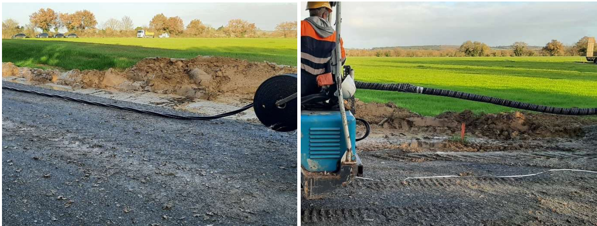
Câble HTA avant et après enrubannage
