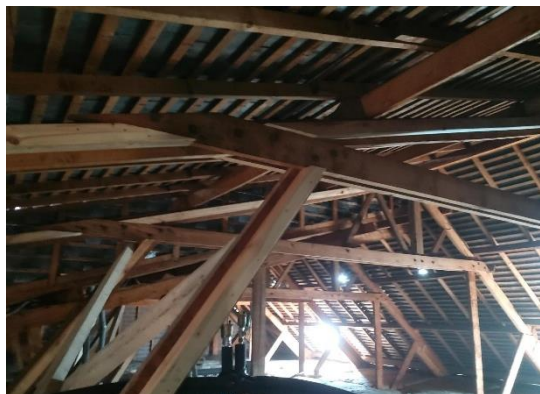
Combles du bâtiment ouest
