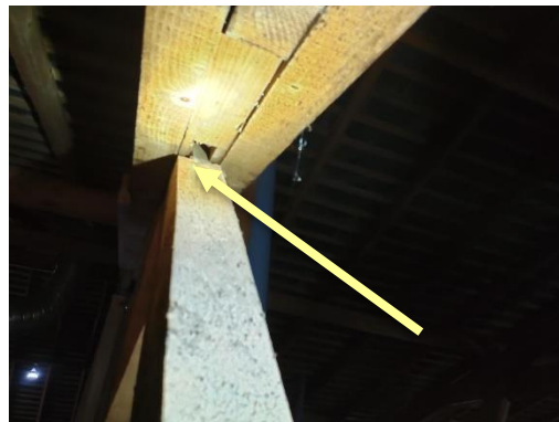
Anfractuosité occupée dans les combles du bâtiment ouest
