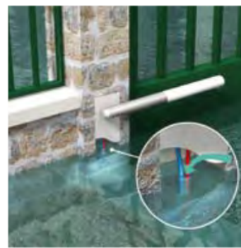
Passage possible de l'eau par les entrées de gaine.
