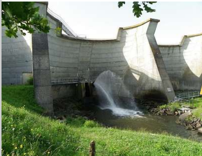
Photo : DDT49 _ Barrage du VERDON
