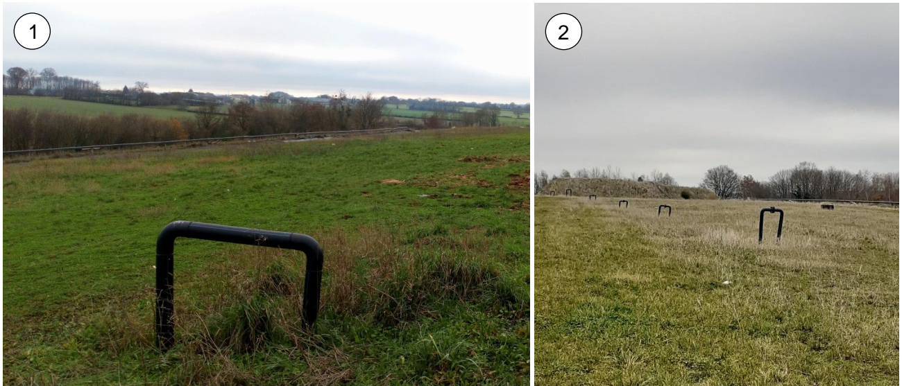
*1 et 2 : exemples de casiers en fin d'exploitation avec leur couverture finale (canalisations de biogaz apparentes)
