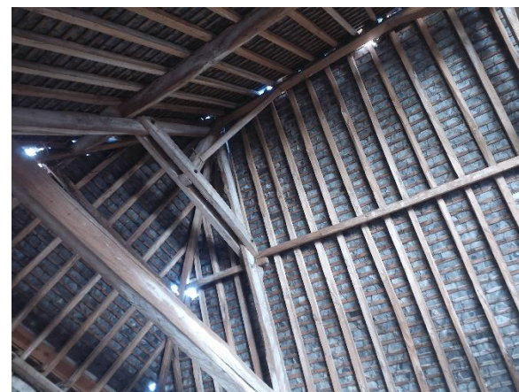
Combles favorables aux chiroptères du bâtiment n°8
