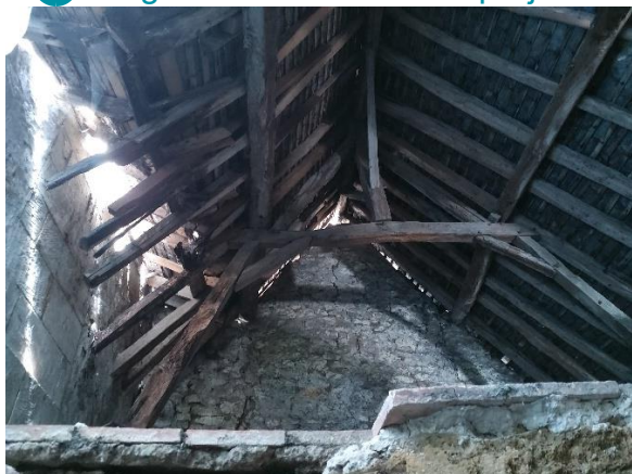
Combles du bâtiment n°2 avec la colonie
