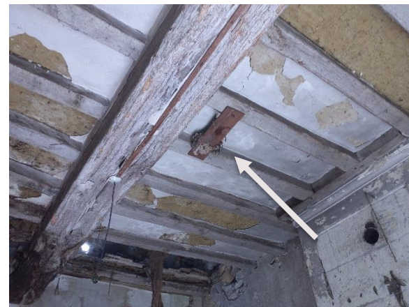
Nid de Rougequeue noir dans le bâtiment n°6
