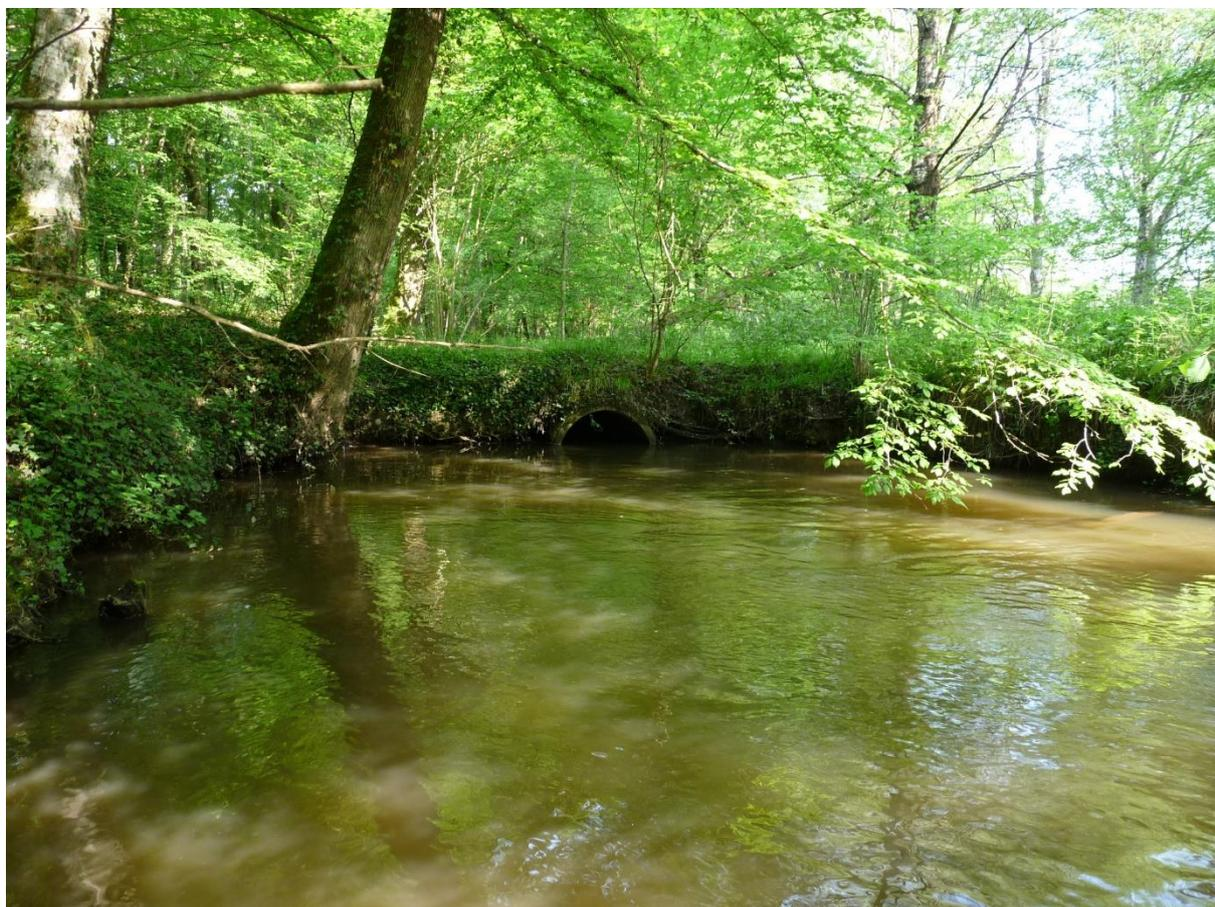
**Figure 27 : Buse sur le cours d'eau, limitant l'écoulement sur ce secteur très forestier**
