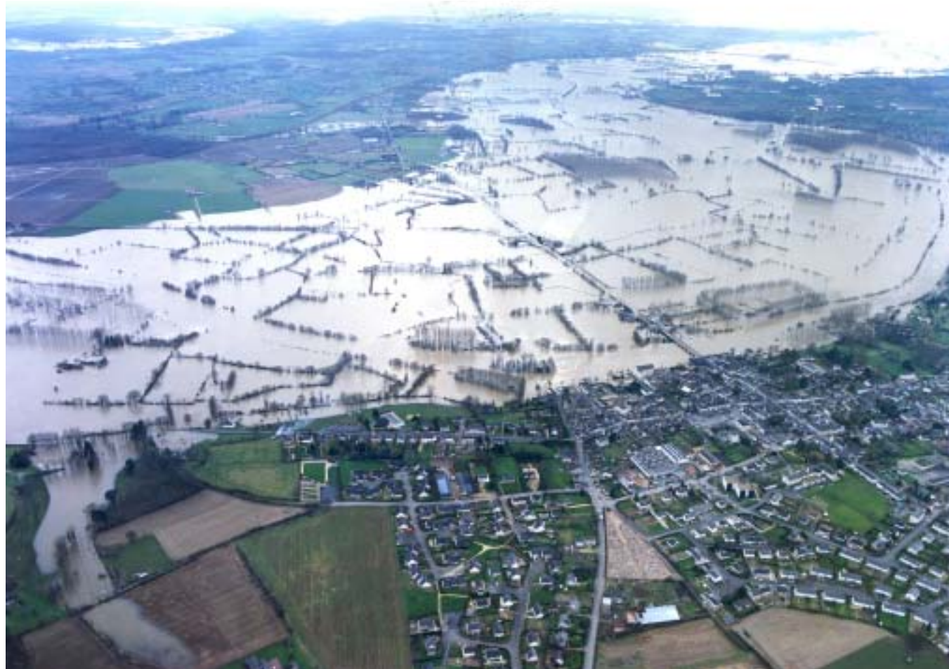
Châteauneuf-sur-Sarthe – crue de 1995 – Photo Edange En haut de la photo, la vallée du Loir
