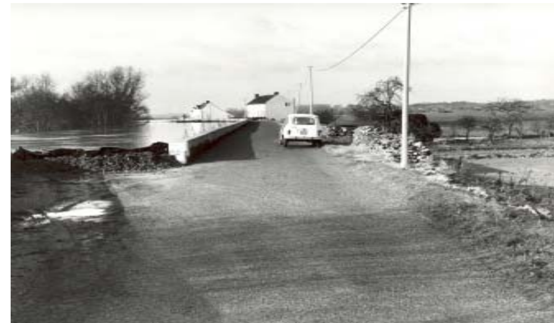
La RD 210 au lieudit « Boyau » - crue de décembre 1982 (photo DDE)
