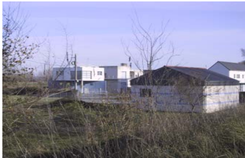
Usine d'eau potable St-Georges-sur-Loire (Photo DDE)
