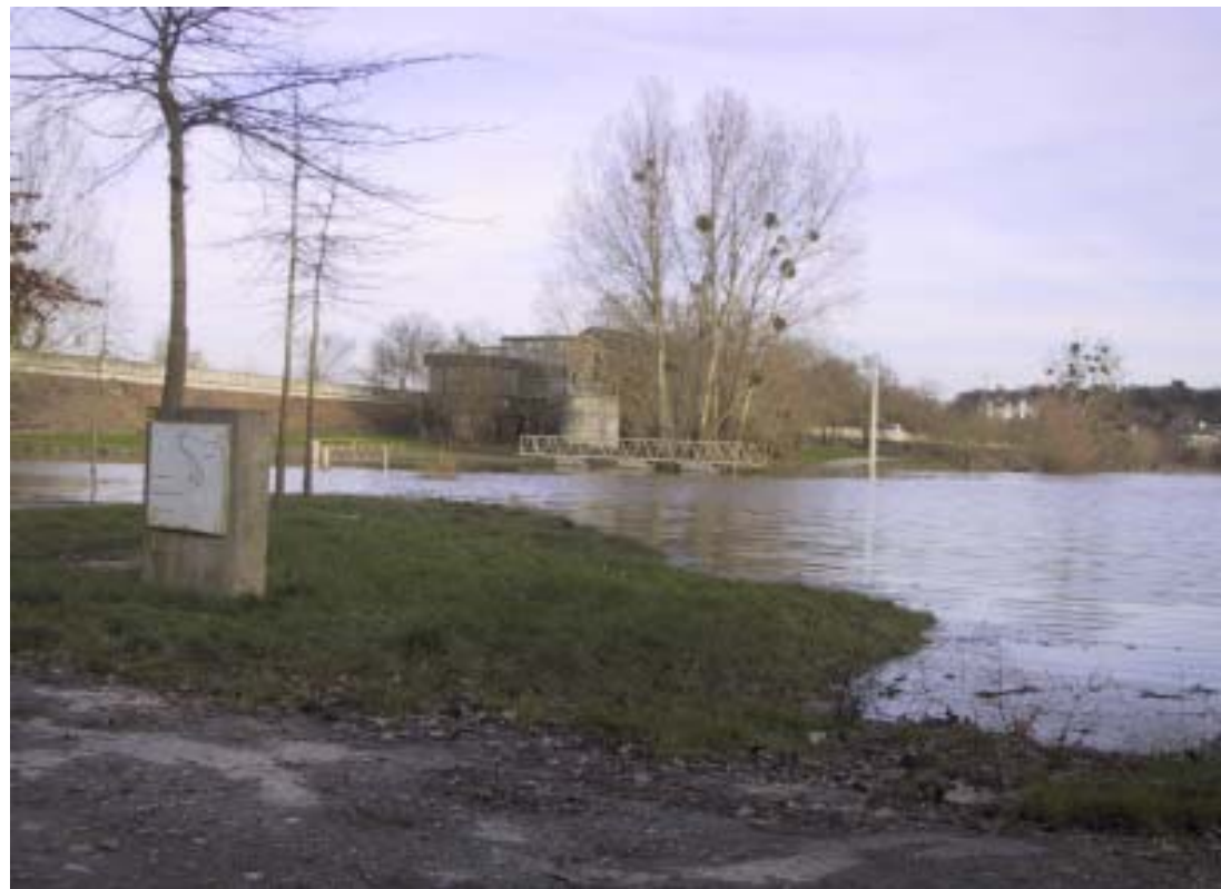
Station d'eau potable Chalennes-sur-Loire (Photo DDE)
