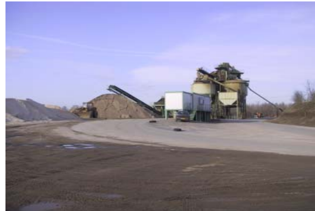
Gravière Sol de Loire – Montjean (Photo DDE)
