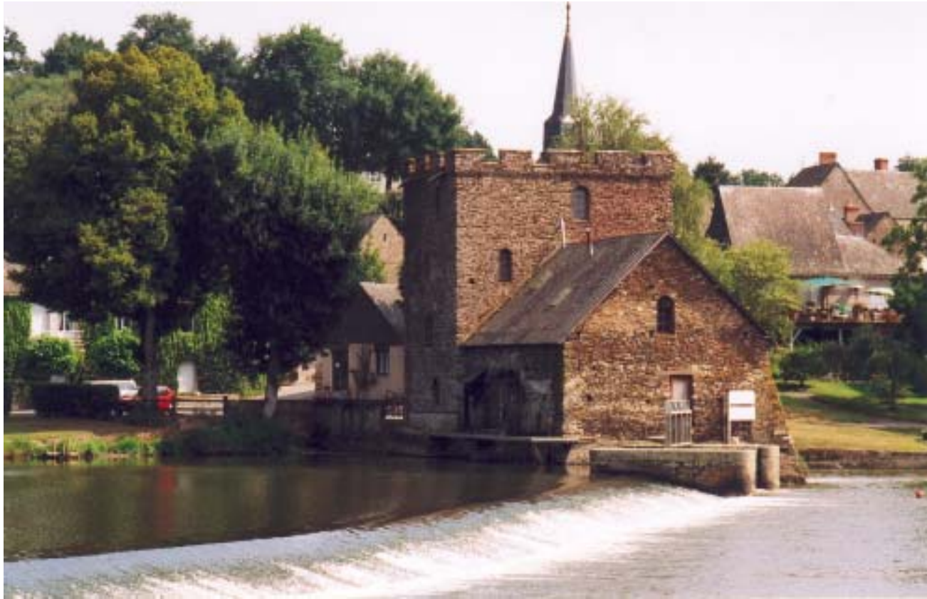
La Mayenne à Chenillé-Changé (Photo DDE)
