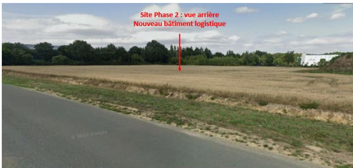
Photo 4 - Vue arrière du site de construction du nouveau bâtiment logistique (Phase 2) en 2022 :
