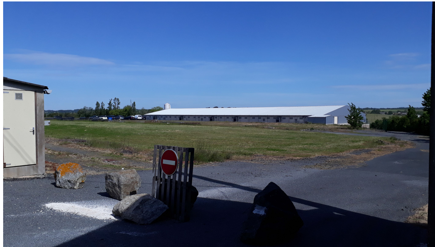
Figure 2 : Vue du terrain de l'emprise du projet photovoltaïque
