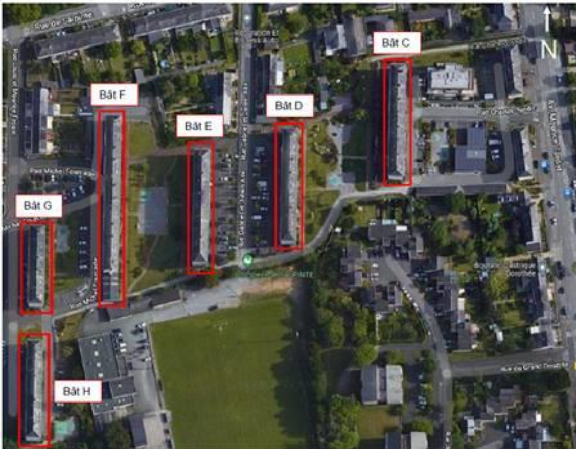
Figure 1 – Localisation des bâtiments Podeliha qui sont rénovés à la résidence Salpinte
