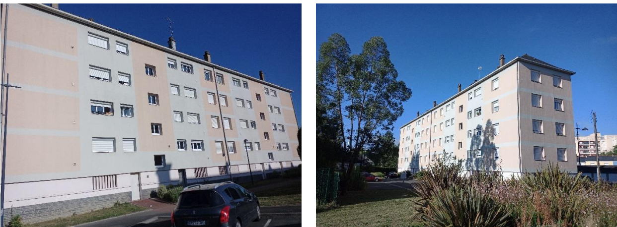
Figure 6 : photo bâtiment G (photo gauche) et photo bâtiment H (photo droite).
