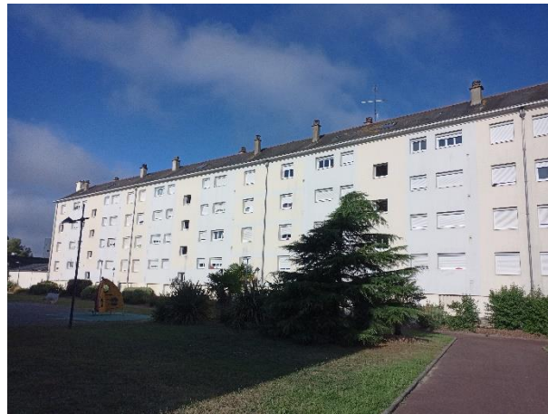
Figure 5 : face est du bâtiment F.
