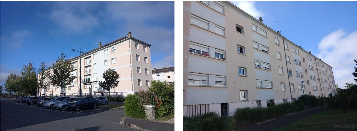
Figure 4 : face est (photo gauche) et face ouest (photo droite) du bâtiment E.
