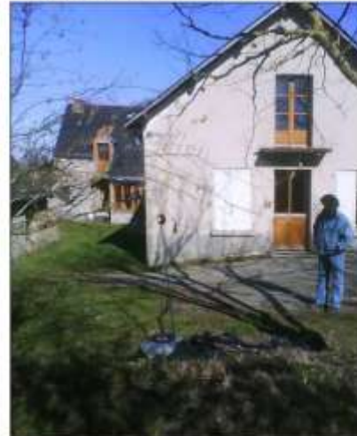
Vue en direction de l'habitation
