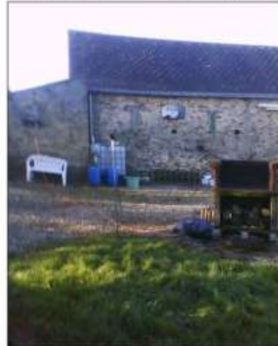
Vue en direction de l'habitation
