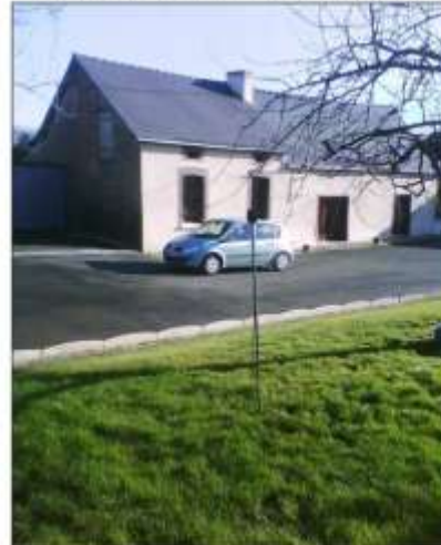
Vue en direction de l'habitation
