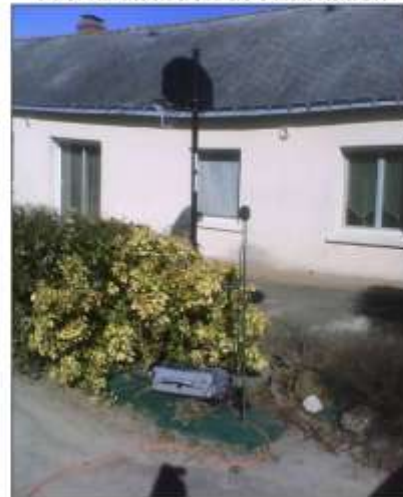
Vue en direction de l'habitation
