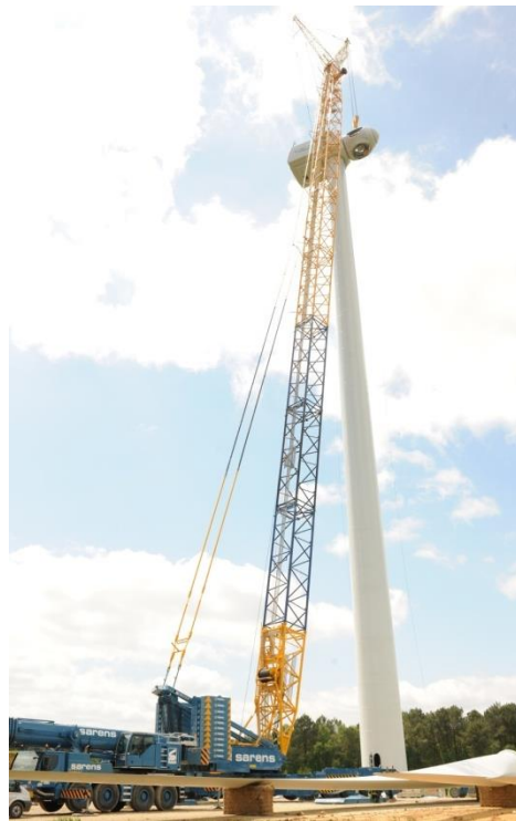
Photographie 5 : Le rotor est assemblé avec la nacelle (photo : Bruno Rouat)
