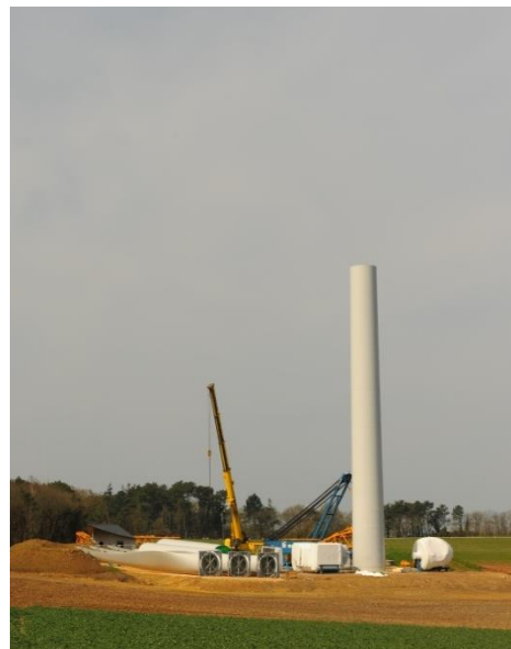
Photographie 2: Montage d'un élément du mât (photo : Bruno Rouat)
