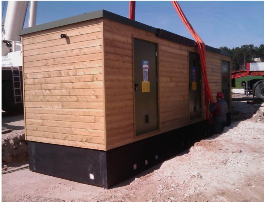
Photographie 1 : Poste de livraison en cours de mise en place (Parc des Landes de Couesmé-56)
