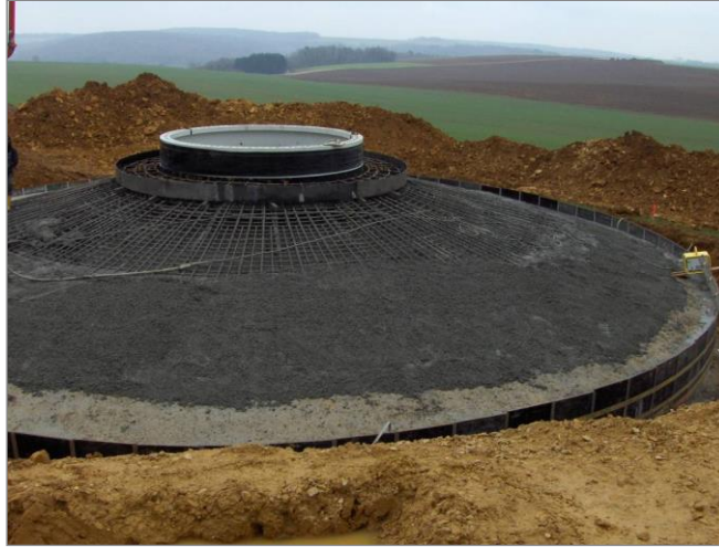
Figure 9 : Exemple de ferrailage en radier pour une éolienne (chantier en cours)
