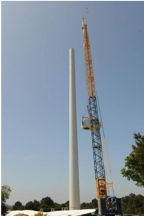
Photographie 4 : levage de la nacelle (photo : Bruno Rouat)
