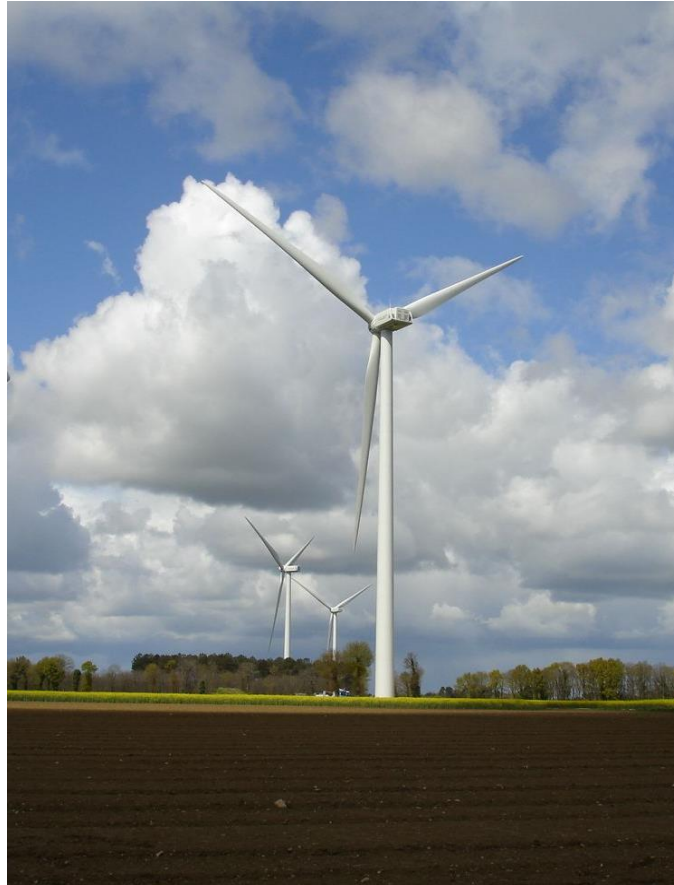
Photographie 8 : Vue sur trois éoliennes montées (photo : Bruno Rouat)
