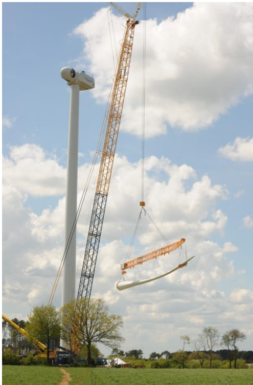
Photographie 6 : montage d'une première pale au rotor (photo : Bruno Rouat)
