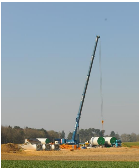
Photographie 3 : déchargement d'éléments du mât (photo : Bruno Rouat)
