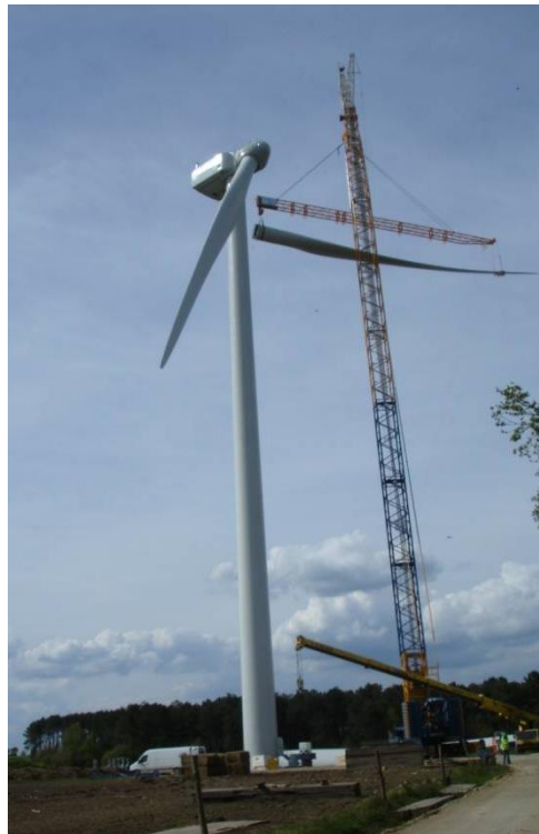
Photographie 7 : montage de la seconde pale
