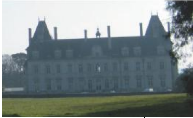
Vue de la façade nord
