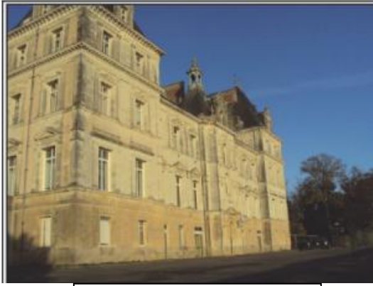
Vue de la façade sud
