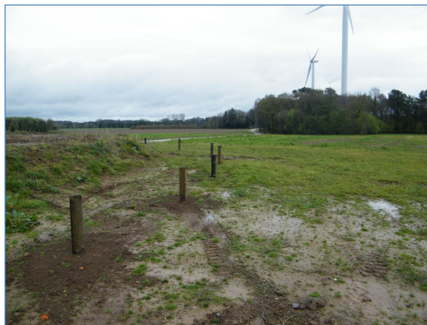
Photographie 2 : installation de piquets pour protéger l'accès à une éolienne, parc éolien de Radenac (56)
