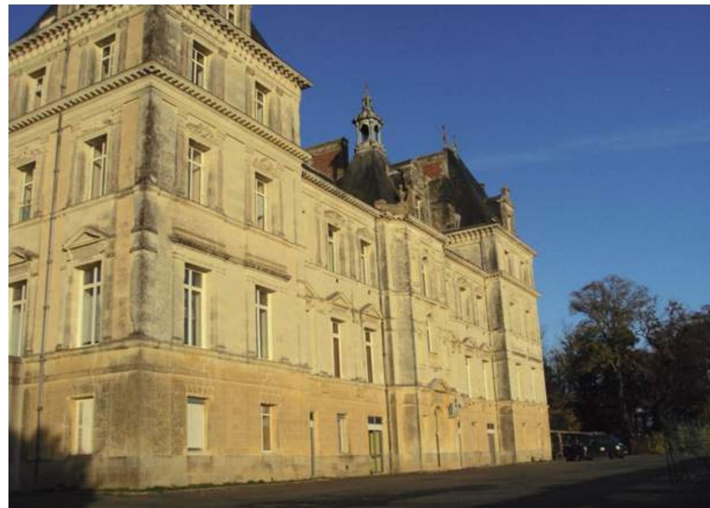
Vue de la façade du château de Tressé depuis la terrasse
