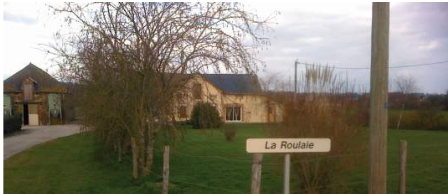
Façade sud dégagée de la Roulais, tournée vers le site
