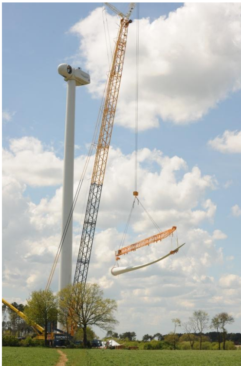
Photographie 23 : montage d'une première pale au rotor (photo : Bruno Rouat)
