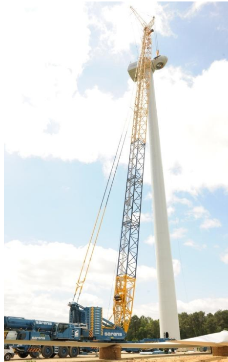
Photographie 22 : Le rotor est assemblé avec la nacelle (photo : Bruno Rouat)
