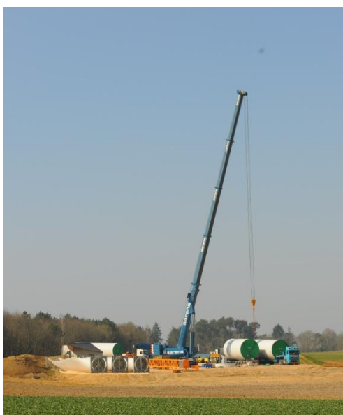
Photographie 20 : déchargement d'éléments du mât (photo : Bruno Rouat)
