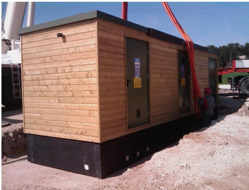
Photographie 16 : Poste de livraison en cours de mise en place (Parc des Landes de Couesmé-56)
