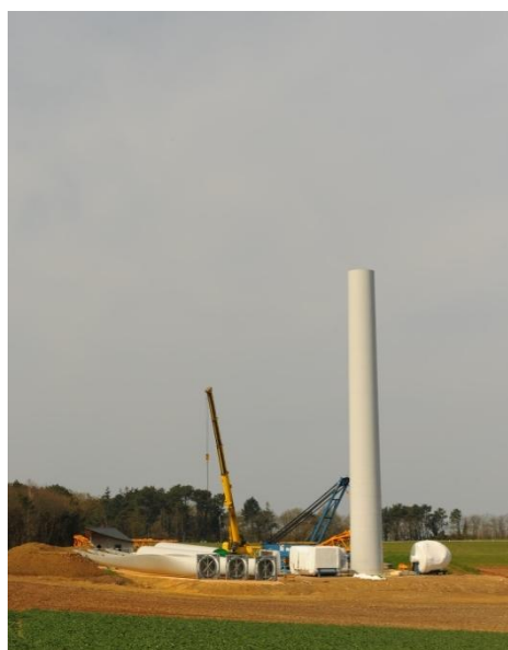
Photographie 19: Montage d'un élément du mât (photo : Bruno Rouat)
