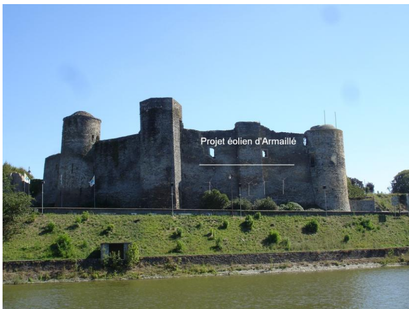
Photomontage 15 : Le château de Pouancé, dans l'alignement face au projet éolien
