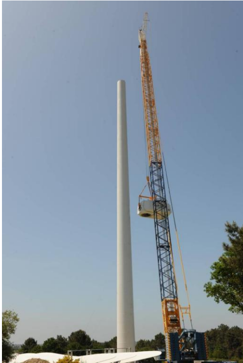
Photographie 21 : levage de la nacelle (photo : Bruno Rouat)
