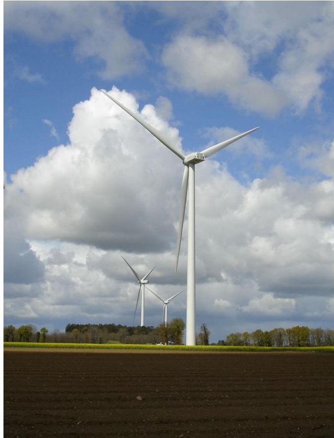
Photographie 25 : Vue sur trois éoliennes montées (photo : Bruno Rouat)
