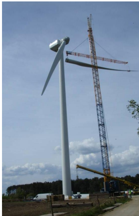
Photographie 24 : montage de la seconde pale
