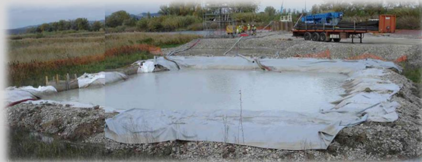
Photo 2 : Bassin provisoire de décantation des MES et autres polluants
