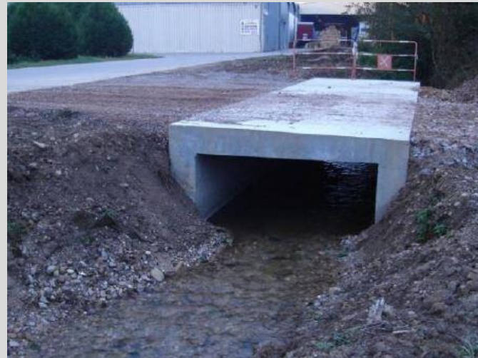
Photo 7 : Photo de principe après mise en place du dalot
