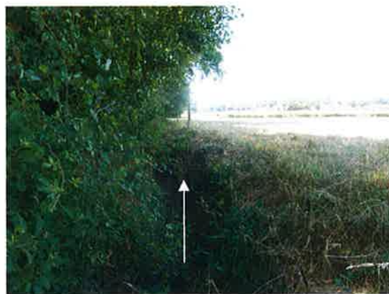
Photo 16 : Vue sur le ruisseau exutoire du projet
