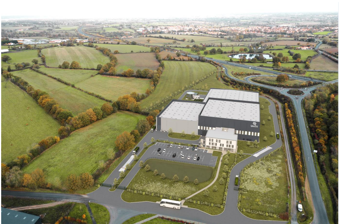
Figure 98 : Modélisation de l'insertion paysagère du site depuis l'entrée du futur centre de tri (source : Triade architectes)
