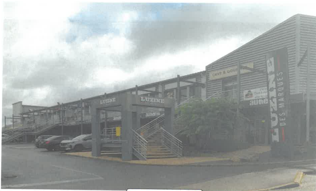
Bâtiment à réhabiliter
