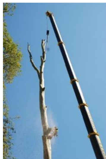
Démontage de la chandelle
