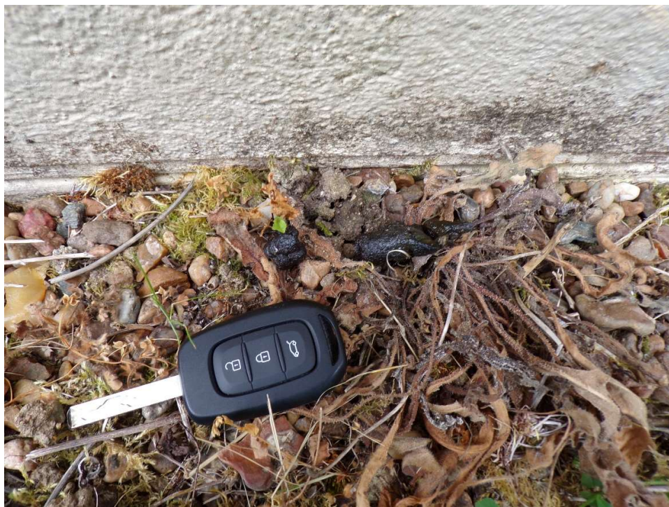
Figure 63 : Crotte observée à proximité de la façade Nord-Ouest du 14 rés. de la Thibaudière
