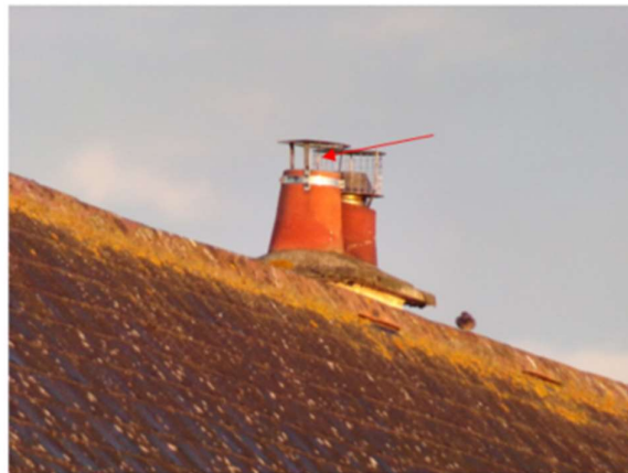
Figure 41 : Localisation du nid de Moineau domestique - 6 rue de la Croix des bas
