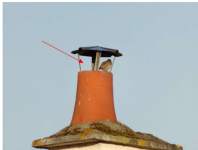
Figure 42 : Localisation du nid de Moineau domestique - 4 rue de la Croix des bas
