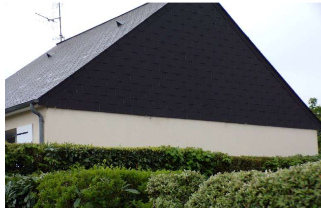
Figure 23 : Bardage ardoise sur le pignon Nord-Ouest du 3 allée de l'Auxence
