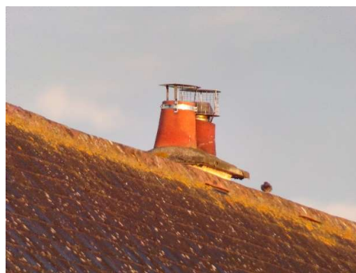
Figure 26 : Exemples de cheminée sur les logements de l'opération 178
