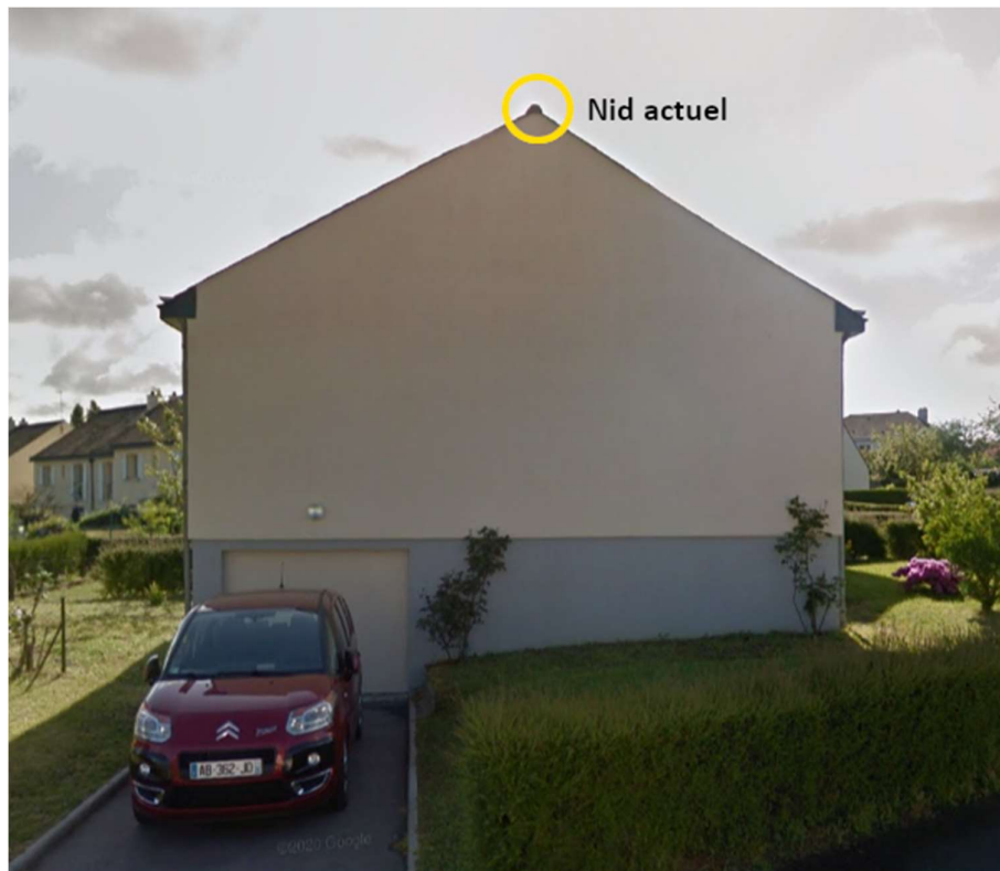
Nid actuel : Façade Ouest 11 rue d'Aquitaine
