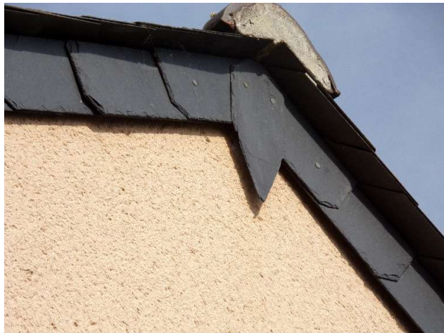
Figure 53 : Ardoises du pignon sous lesquelles les chiroptères peuvent se glisser
