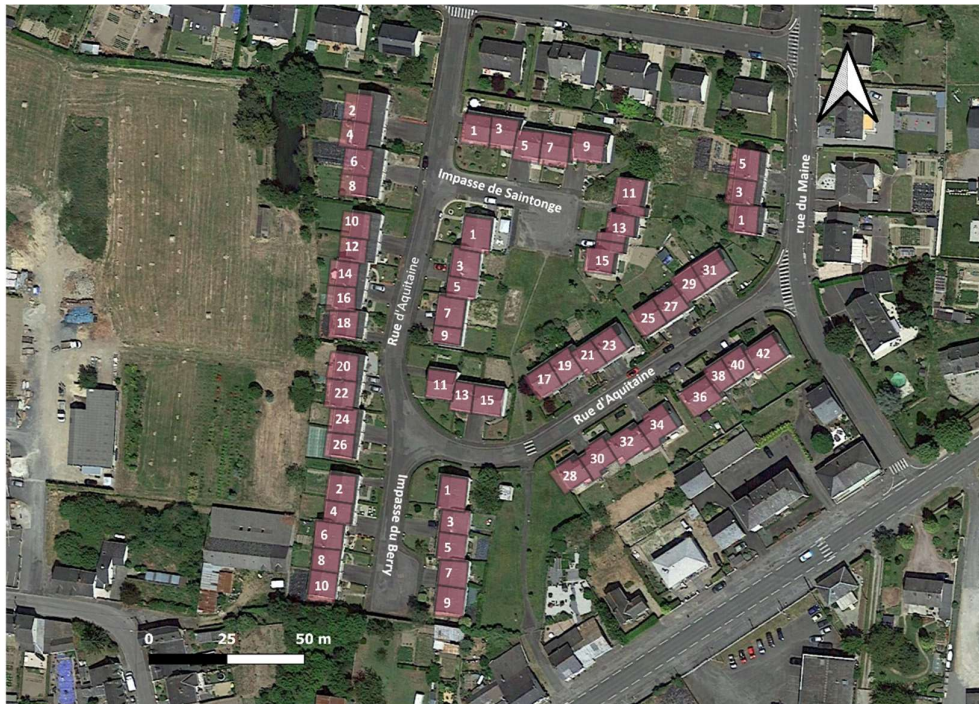
Figure 10 : Photographie satellite du site de l'opération 217 & 296
