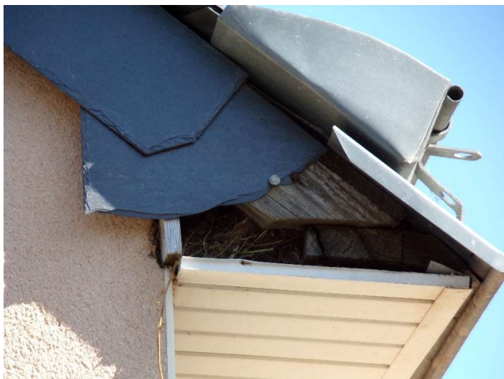
Figure 10 : Exemple d'accès aux espaces sous-toiture et au cache-moineaux
