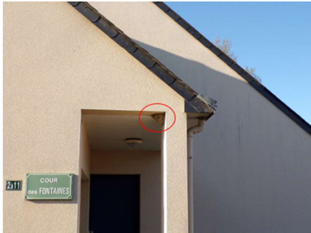
Figure 40 : Localisation nid Hironnelle de Fenêtre – 13 rue des Fontaines
