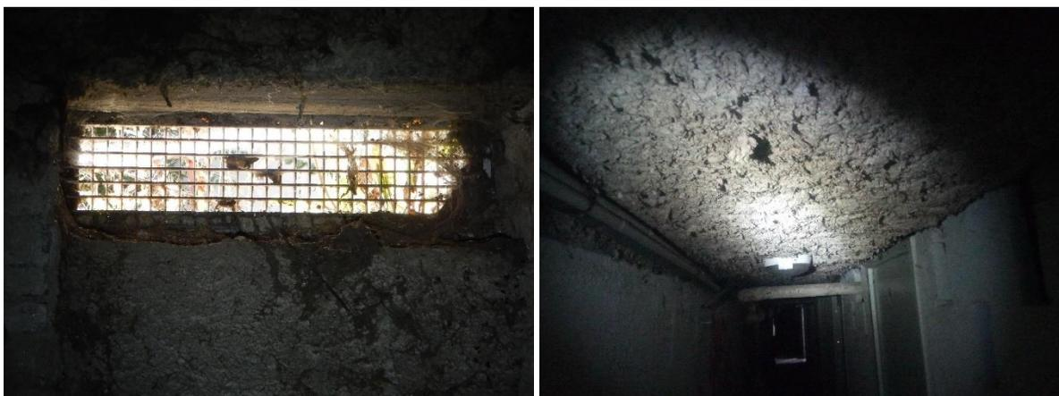
*Figure 23 : Illustration d'un soupirail équipé d'une grille limitant le passage des chiroptères (à gauche) et de l'isolation projetée au plafond des caves (à droite).*
