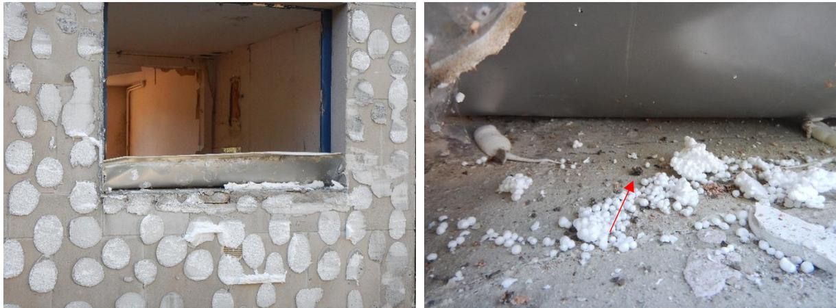
**Figure 28 : Illustration d'un rebord de fenêtre arraché suite aux travaux et de guano présent sous ce rebord de fenêtre.**
