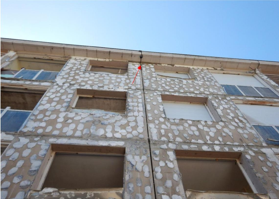
*Figure 32 : Illustration d'un des disjointements occupé sur le bâtiment du 15 / 17 / 19 boulevard Beaussier*
