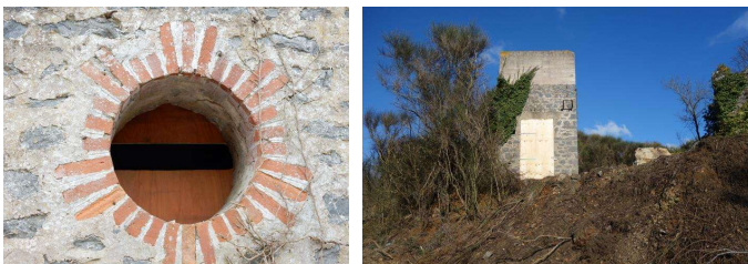
Aménagement de l'ancienne maison de carrier en faveur des chiroptères
