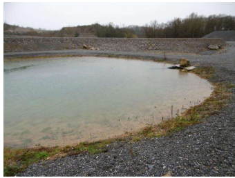
Bassin de décantation
