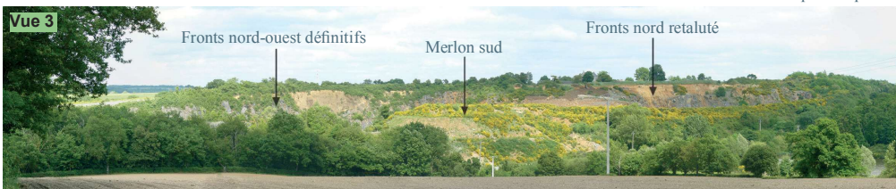
Vue prise depuis le chemin près de la Turpinière
