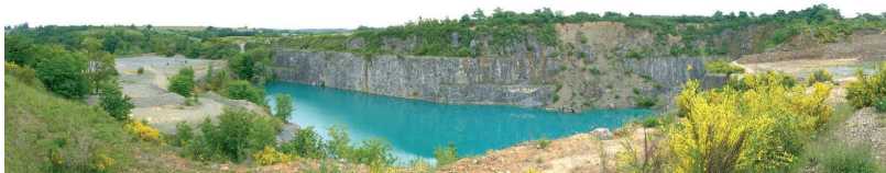
Vue depuis le merlon sud sur les fronts nord-ouest et la plate-forme ouest
