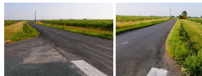
▲ Le stop sur le chemin d'accès à la carrière et la visibilité à gauche et à droite sur la RD 106 est bonne.
