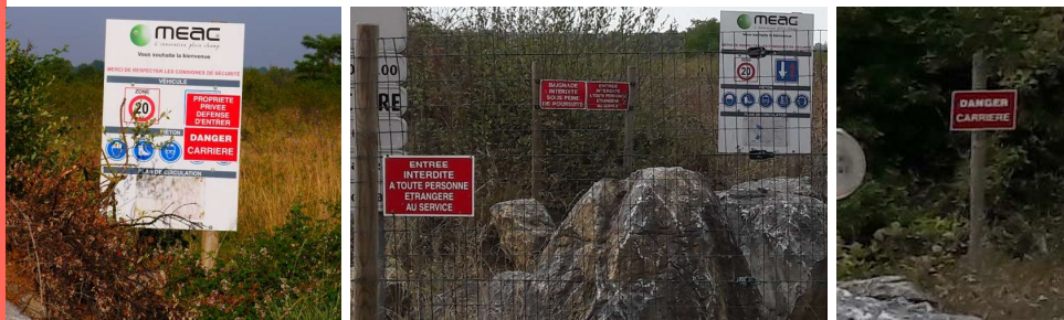
▲ La clôture et la signalisation en périphérie du site
