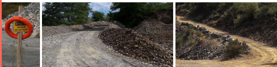
▲ Bouée, merlon et blocs en bordure des pistes
