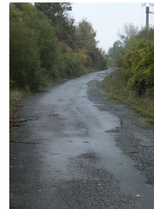
▶ La voie d'accès en matériaux enrobés
