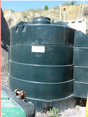
▲ Exemple de citerne à double paroi
