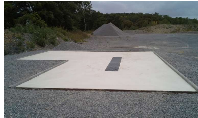
▲ L'aire étanche sur le site
