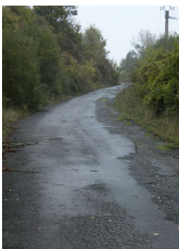
▲ Voie d'accès enrobée
